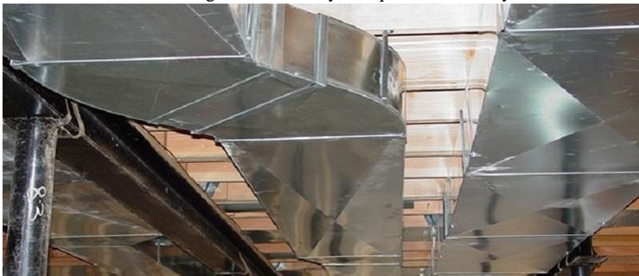
38 rasm. Korxonaning shamollatish tizimi.
