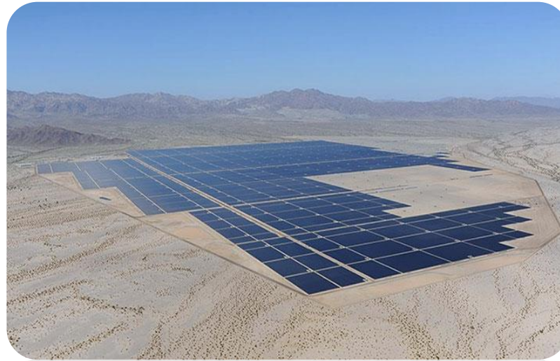
Солнечные панели установлены в Калифорнии
