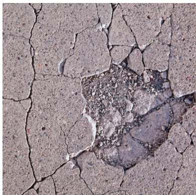
2-rasm. Kanallarining temir-beton qoplamalaridagi asosiy texnik nuqsonlar: a – Hamdam kanalida; b – Do'stlik kanalida.
