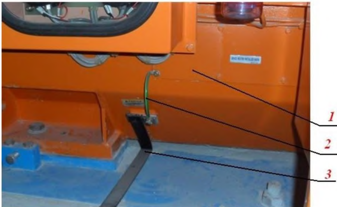
1-rasm. Elektr dvigatelning yerlashtirish tizimiga ulanishi. 1-elektr dvigatel; 2-yerlashnirish otkazgichi; 3- yerlashnirish shinasi.
