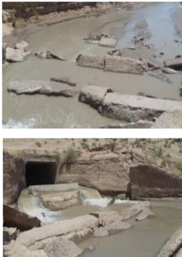
Рисунок 1. Современное состояние нижнего бьефа водопропускного сооружения
