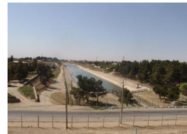
Рис.5. Правый сбросной канал
