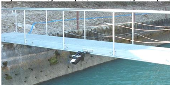
1–расм. Очик ўзанли каналга ўрнатилган Raven-Eye сув ўлчаш қурилмаси
