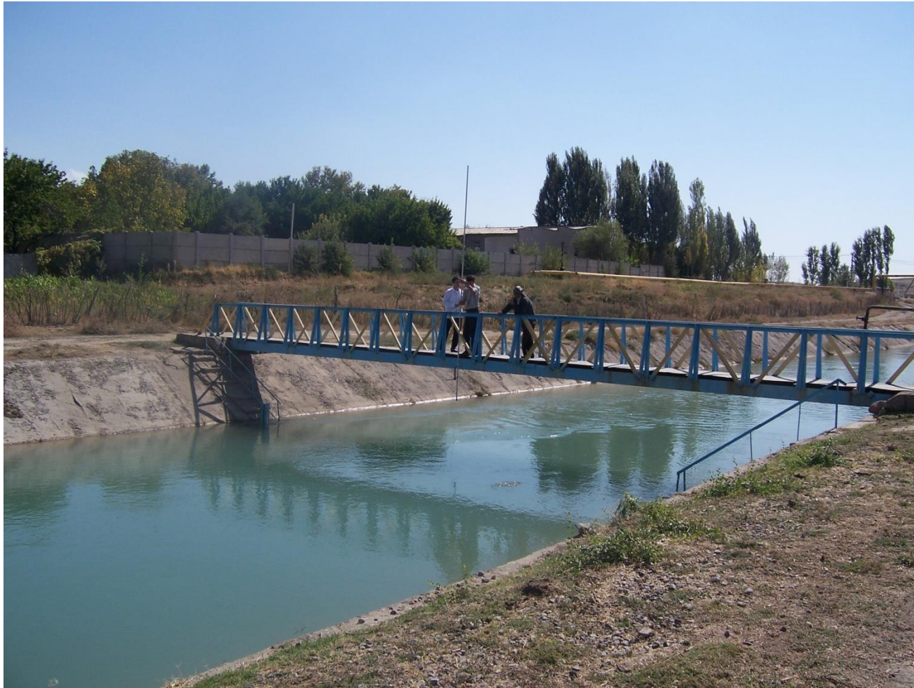
Паркент каналидаги гидропост
