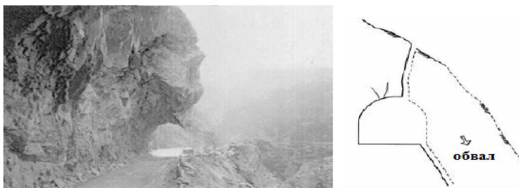
Рис. 2. Вид повреждения - обрушение откоса вызвало разрушение тоннеля
