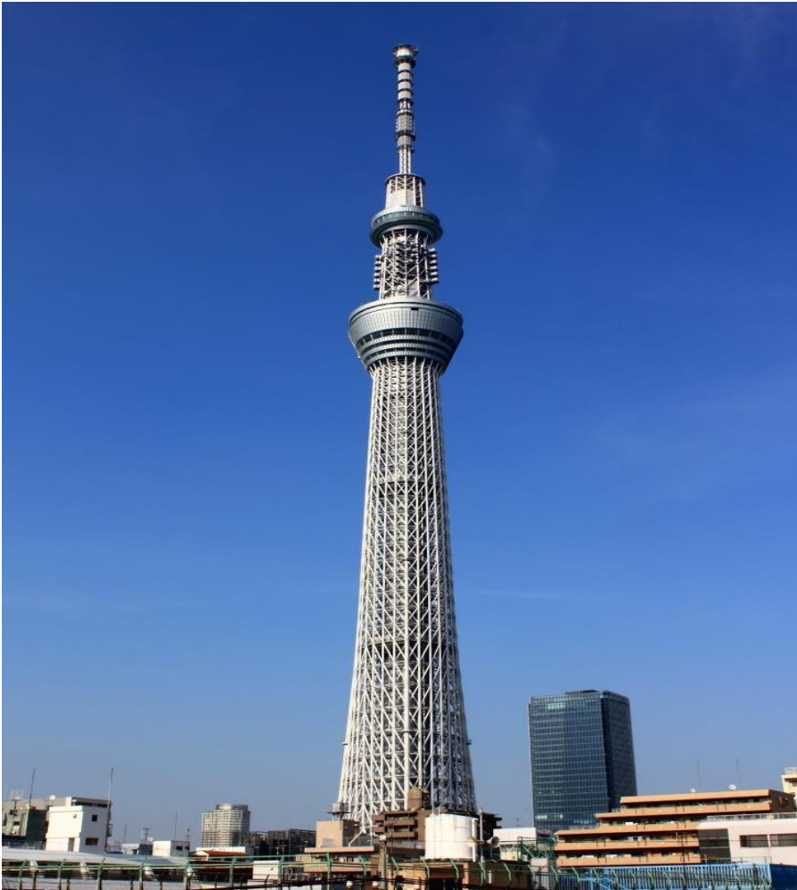
Небесное дерево в Токио. Самая высокая телебашня (634 м). Построена в 2012 году .
