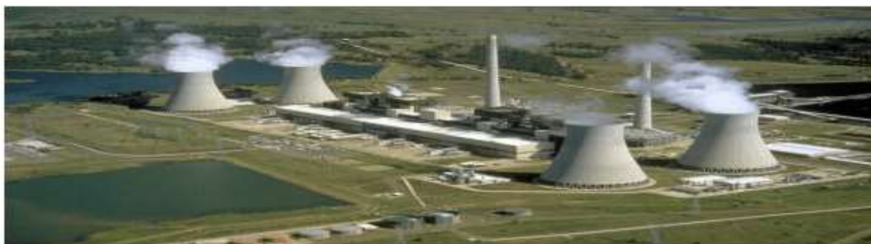
1-rasm. Atom elektr stansiyasi ko'rinishi.
