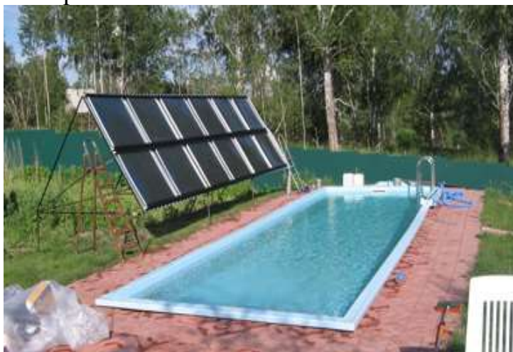
Рисунок 2. Схема обогрева бассейна с помощью солнечного коллектора.
