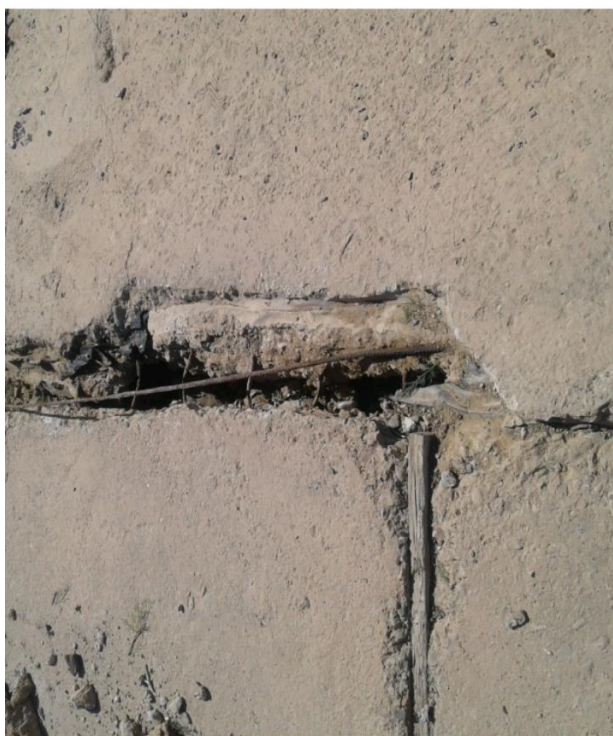
1-расм. Гидротехника иншоотларидаги темир-бетон плиталарининг сув сатҳи ўзгарниб турадиган қисмларидаги бузилишлар
