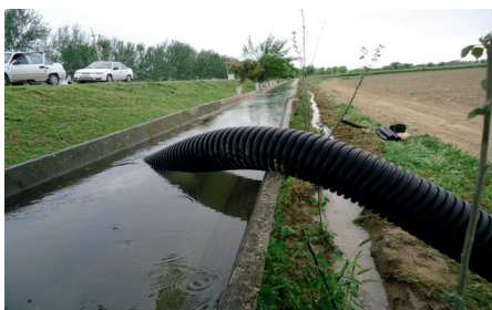
15-расм. Лоток тармоғидан сифон ёрдамида сув олиш
