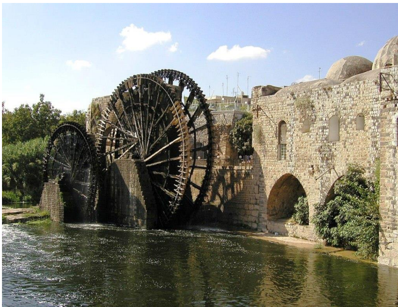
Рис. 14. Водоподъёмный механизм «нория»
