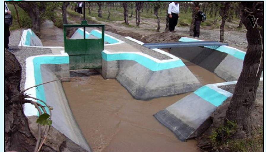
Водомерное и водовыпускное сооружение
