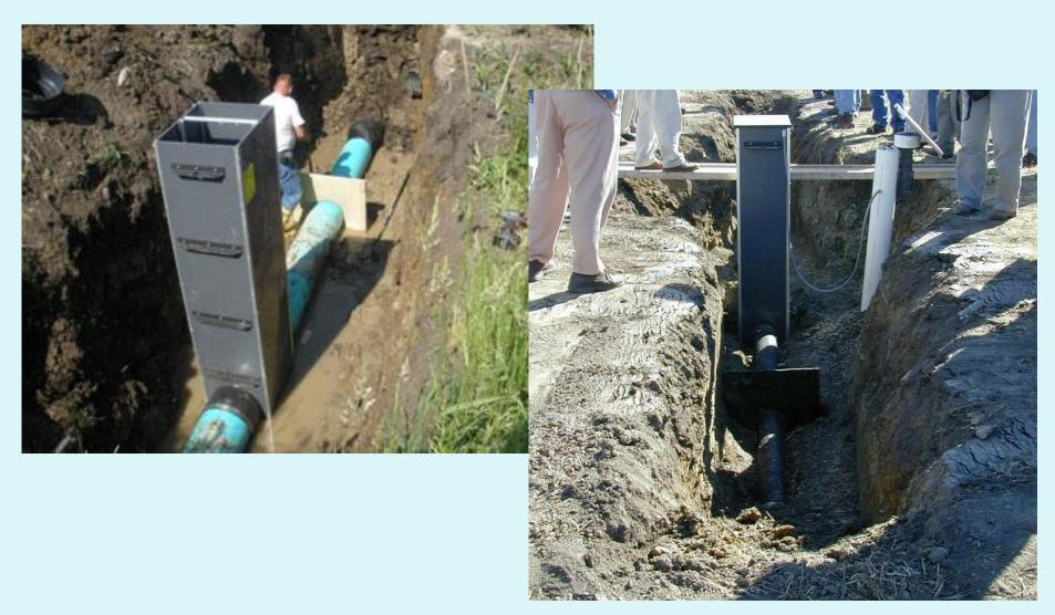
Тиничный блок управления дренажа состоит из стояка с подвижными затворами, или стоп-логами, для подъема или опускания высоты выхода и при этом высоты воды.
