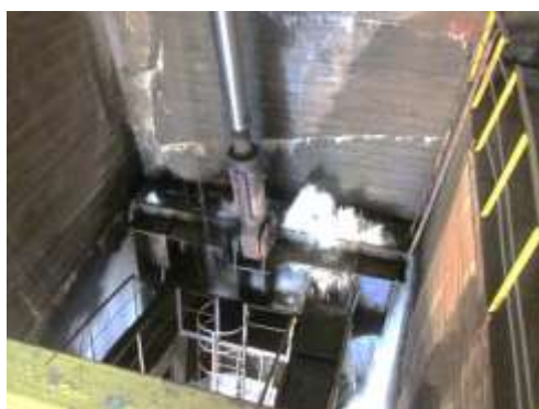
2-расм. Ишчи сегментли 4,5х5,0 м.ли затворнинг бугунги ҳолати.
