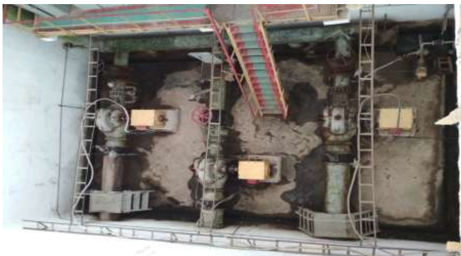
1-rasm. Drenaj nasos stansiyasining shaxta qismi va unda joylashgan nasos agregatlari holati [1].
