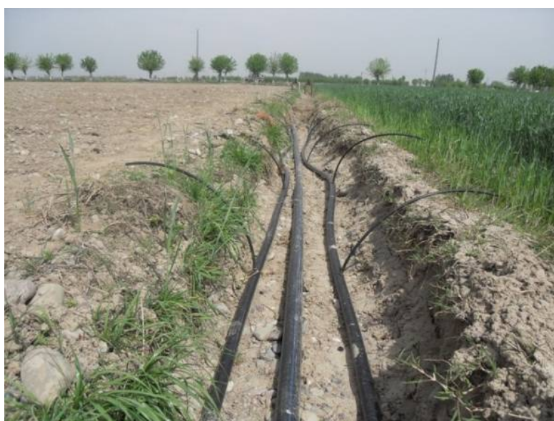
Система в процессе установки на поле
