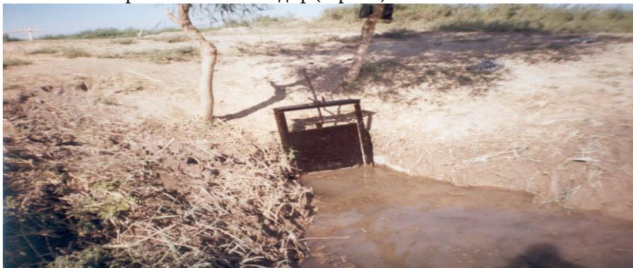
1-расм. Бирламчи зовур охиридаги сув тўсувчи иншоот.
