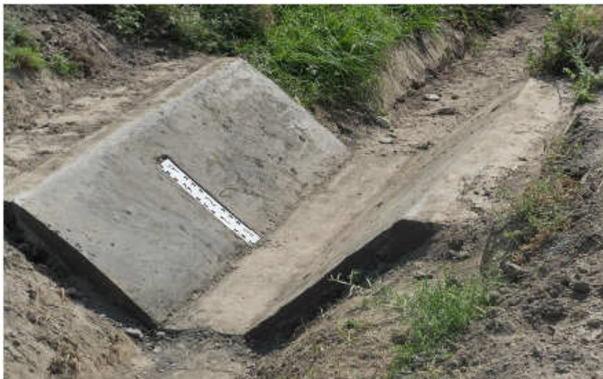
51-rasm. O'zgarmas o'zan turidagi gidropost
