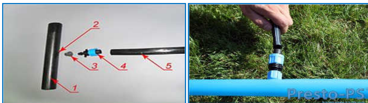
28-rasm. Tomchilatuvchi lentalarni ulash.
