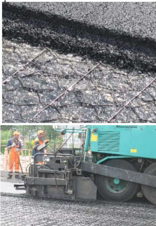
Рис 1. Технология применения стальной проволоки.
