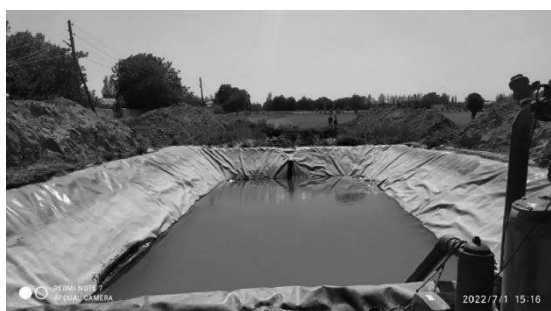
1-расм. “Қоратери Ботир пахтаси” фермер хўжалигидаги томчилатиб суғориш тизимидаги мембранали тиндиргич.
