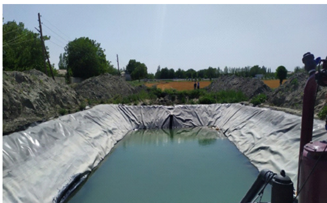
1-расм. “Қоратери Ботир пахтаси” фермер хўжалигидаги томчилатиб суғориш тизимидаги мембрнали тиндиргич
