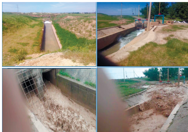
3-расм. "Лангар" сел-сув омборидан сел-тошқинларини ўтказишдан сўнг сув чиқариш иншоотидаги носозликлар
