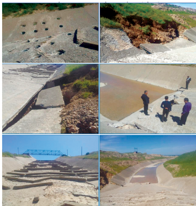
2-расм. "Лангар" сел-сув омбори сув ташлама иншоотида сел оқимининг келиши оқибатида шикастланишлари
