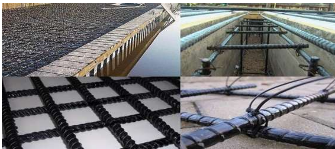
1-расм. Қурилиш соҳасида қўлланилаётган базальтопластик арматуралар.
