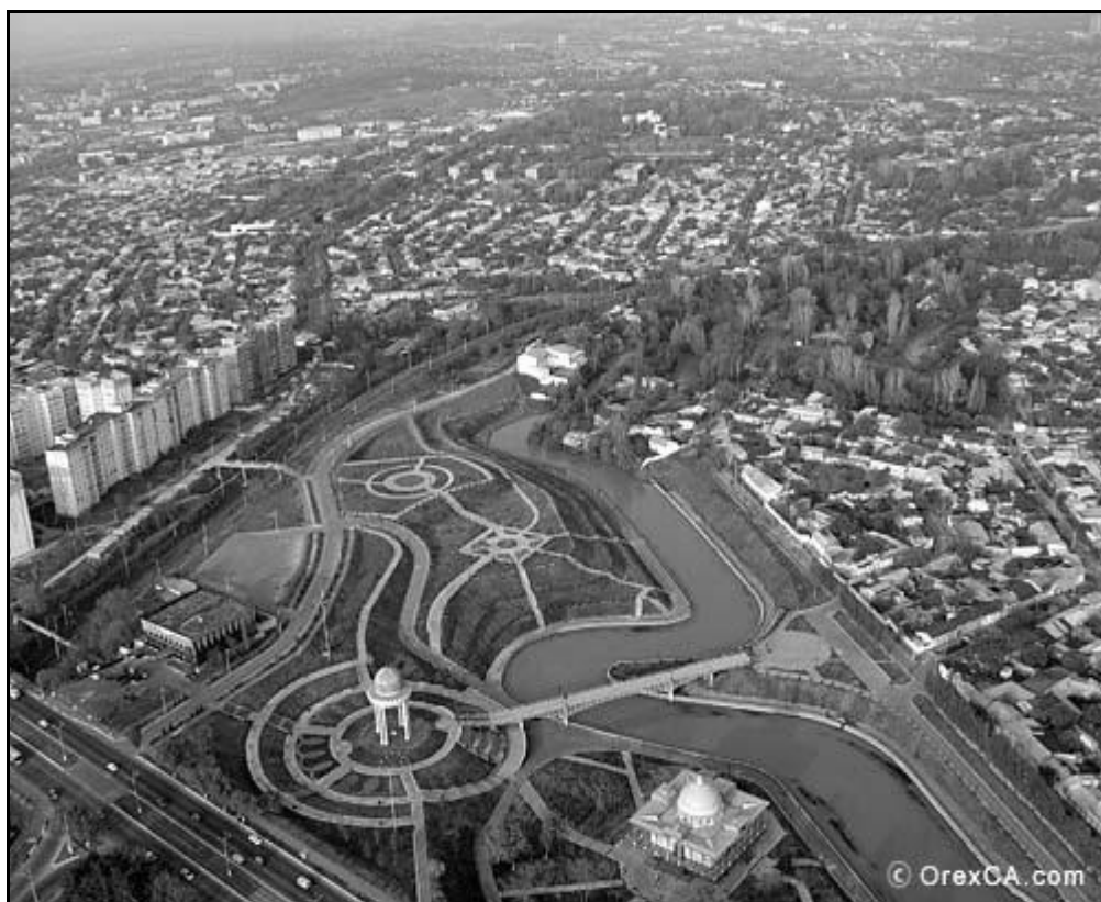
2.13- rasm. Anhor kanalining ko'rinishi.
