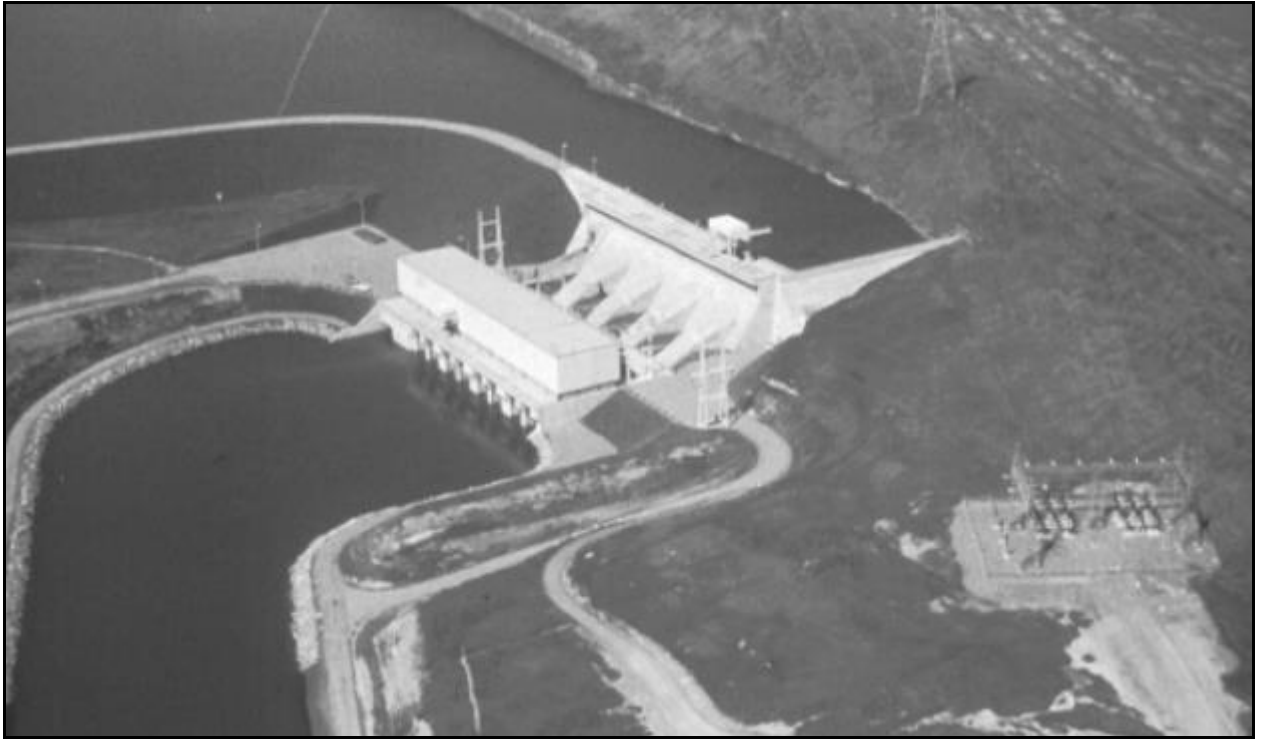
2.12- rasm. Nasos stansiyasining ko‘rinishi.
