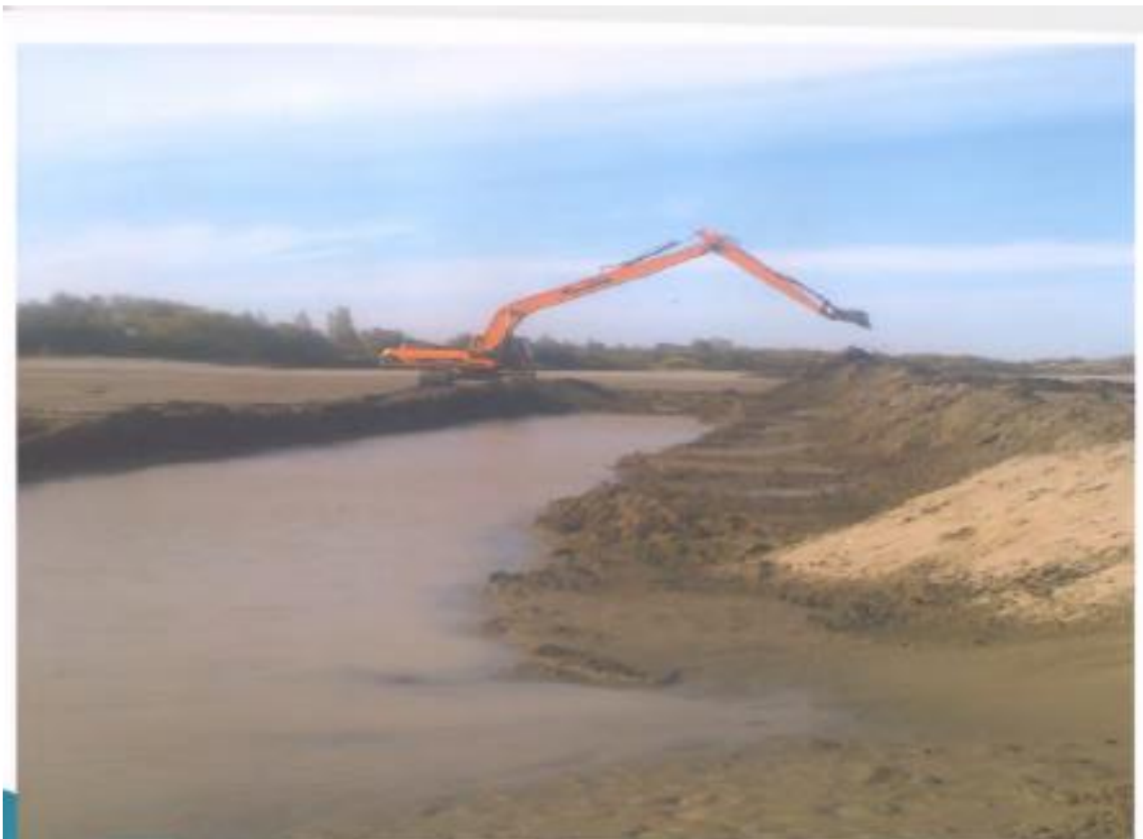
3.9-расм. Қипчоқ-арна каналига сув келтиручи ўзанини тозалаш
