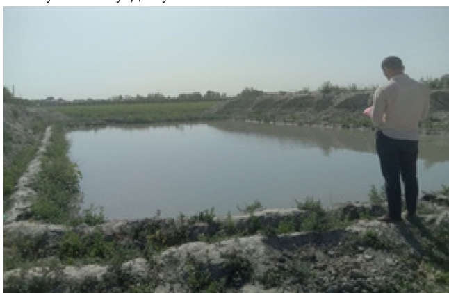
5-расм. “Асалчи Элдор” фермер хўжалигидаги томчилатиб суғориш тизимидаги мембранасиз тиндиргич
