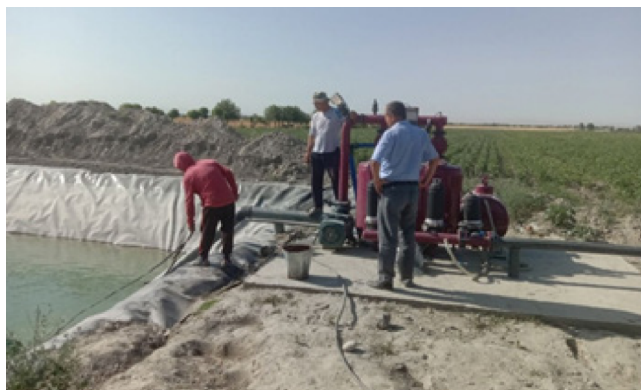
4-расм. “Маликов Ахмад” фермер хўжалигидаги томчилатиб суғориш тизимидаги мембранали тиндиргич
