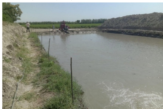
7-расм. “Қодир Эшқуватов” фермер хўжалигидаги томчилатиб суғориш тизимидаги мембранасиз тиндиргич
