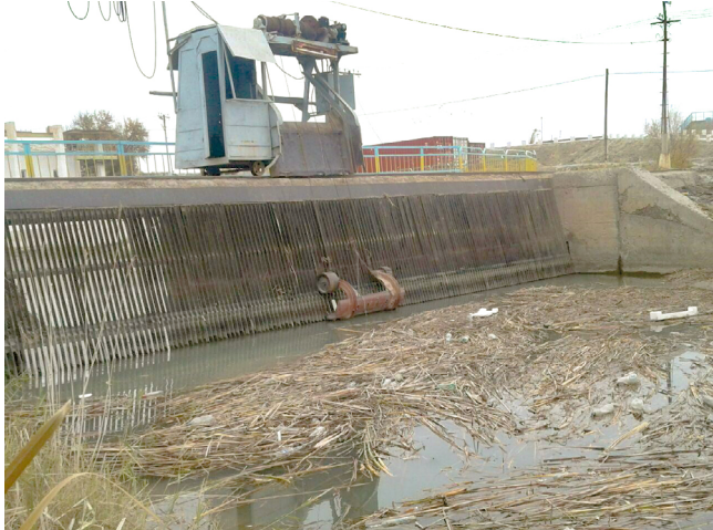
2-расм. Иншоот олдида йиғилиб қолган муаллақ оқизикларни тозалаш жараёни.
