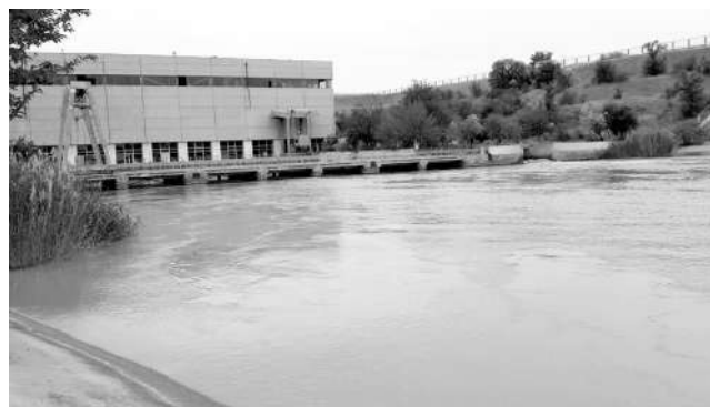
Рисунок 3. Аванкамера насосной станции № 6 КМК.
