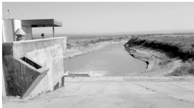
Рисунок 2. Водовыпускное сооружение насосной станции № 7 КМК в Талимарджанское водохранилище.
