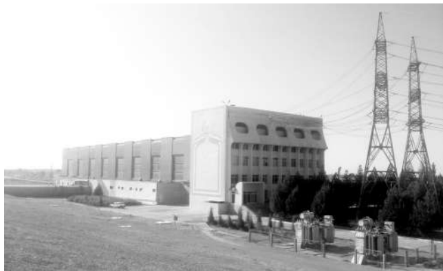
Рисунок 1. Насосная станция № 7 КМК.
