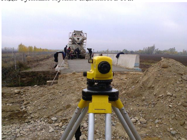
1 - расм. Leica NA720 замонавий рақамли нивелир
