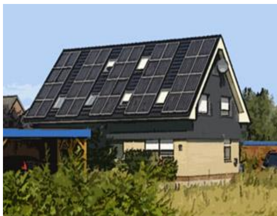
2.1-rasm. Qurulish inshootiga qo'llangan fotoelementlar.
