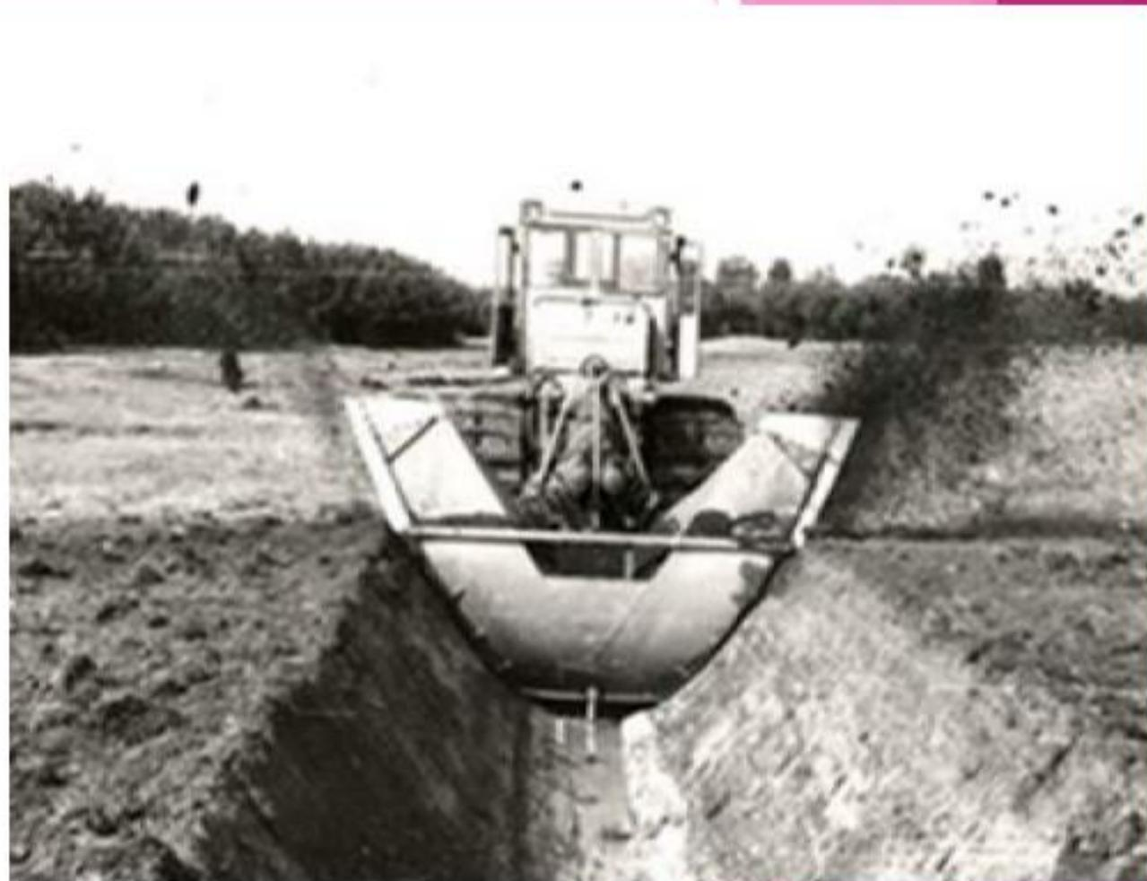
Каналокопатель для нарезки каналов параболического сечения
