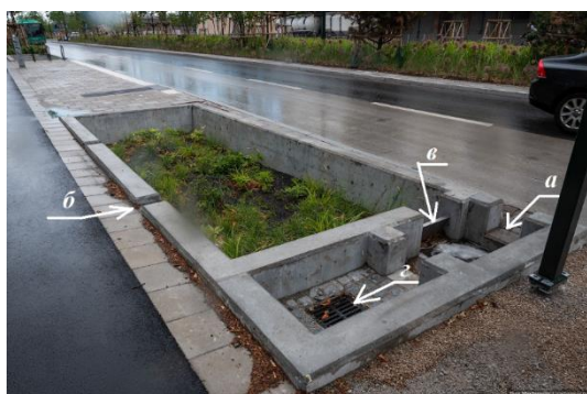
Рисунок 3. Дождевой горшок, собирающий ливневые стоки с проезжей части и тротуара
