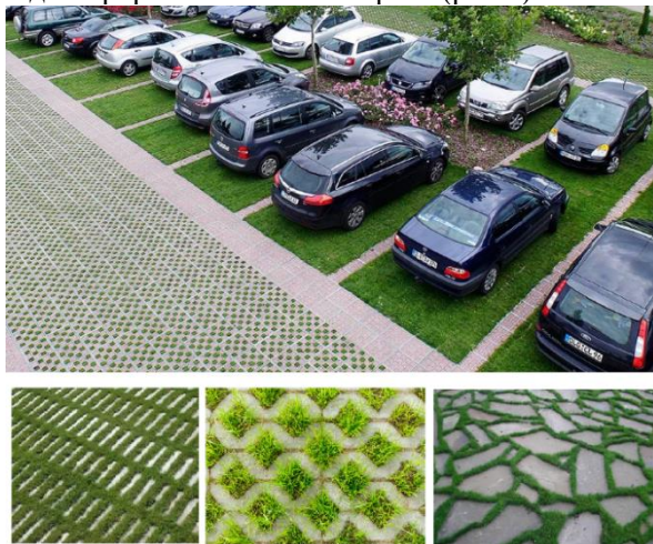
Рисунок 5 Пример обустройства экопарковки, которая свободно впитывает дождевую воду
