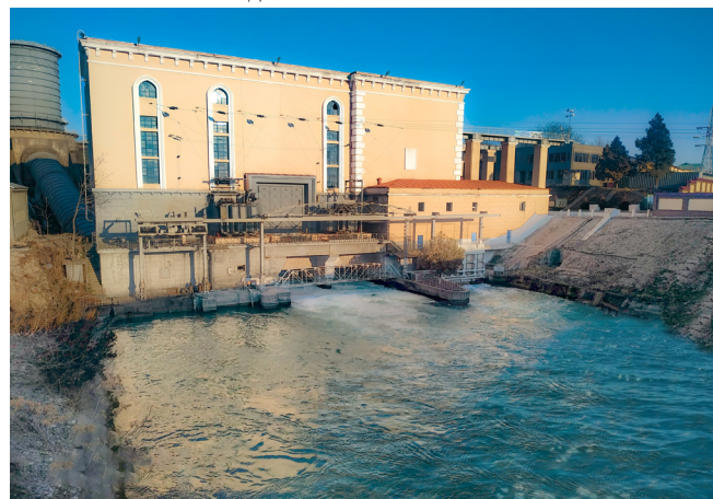
Рис.3. Сооружения и оборудование Ак-Кавакская ГЭС №1
