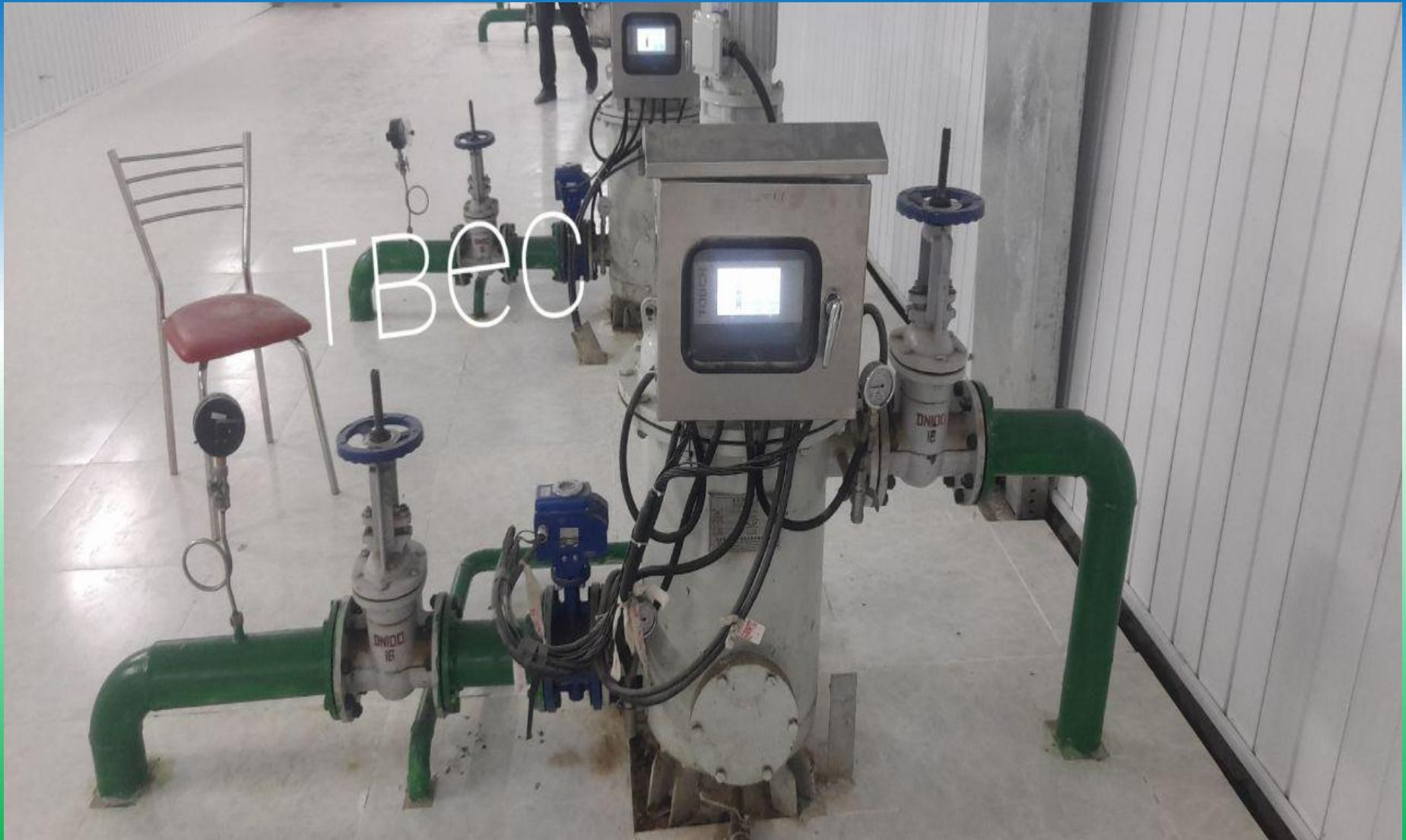
Irrigasiya tizimlarida o'rnatilgan GESlarda texnik suv ta'minoti tizimi doimiy ishlamaydi, moylash tizimiga suv berish to'xtatiladi, GES agregatini o'chiruvchi automatic qurilma muntazam tekshirilib turilishi, sig'imlar, suv tindirgichlar filtrlari yuvilib turilishi lozim.
