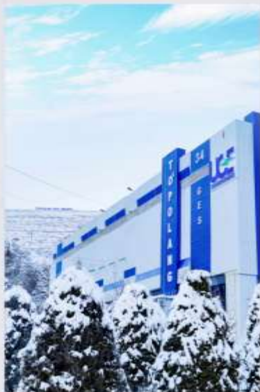
To'polang GES modernizatsiyasi (175 MVt);
