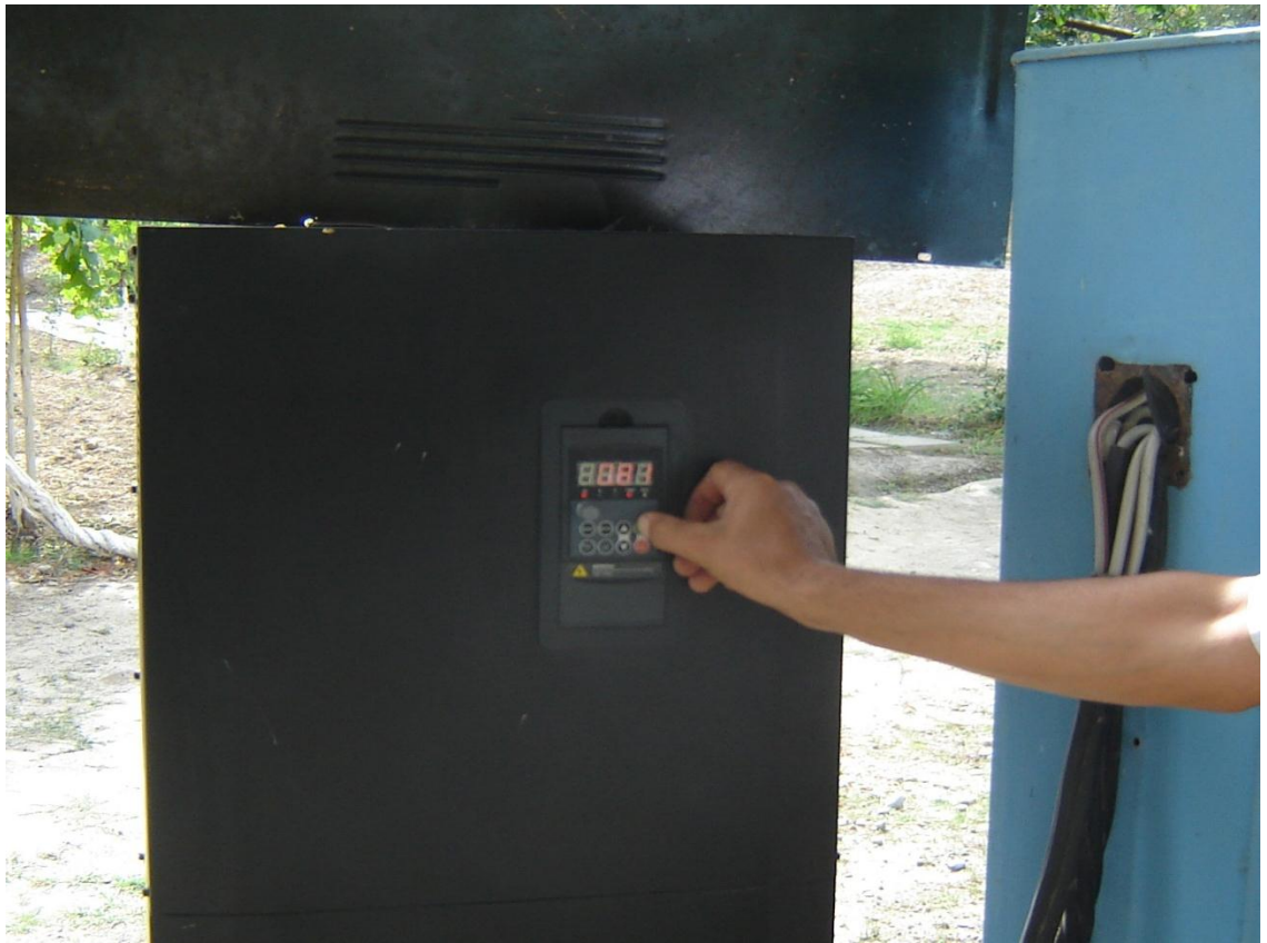
Рис.3.22. Изменение числа оборотов рабочего колеса насоса при помощи частотного преобразователя
