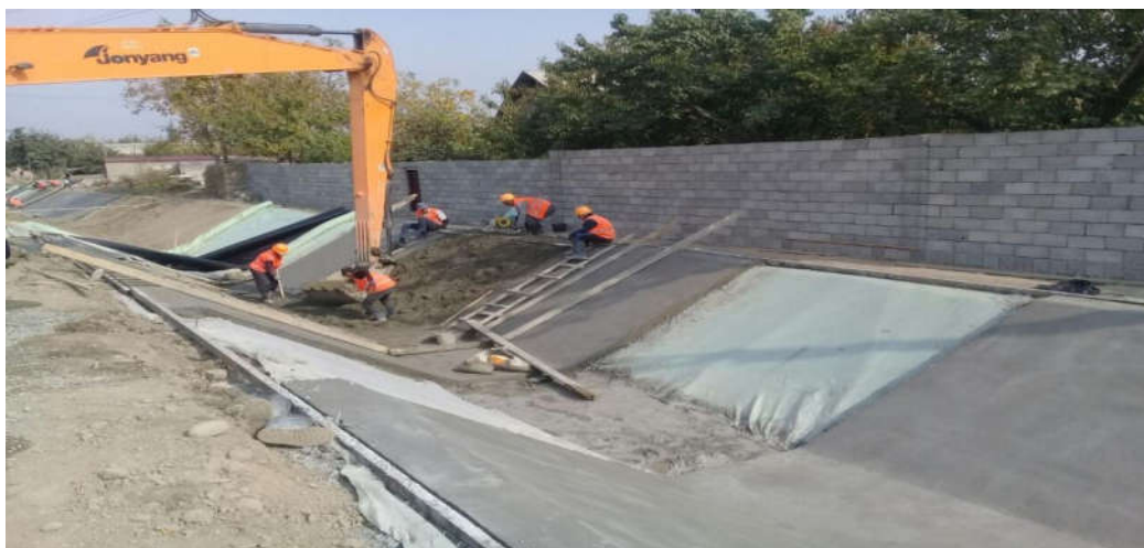
2-расм. Суғориш тармоқларини бетонлаш
