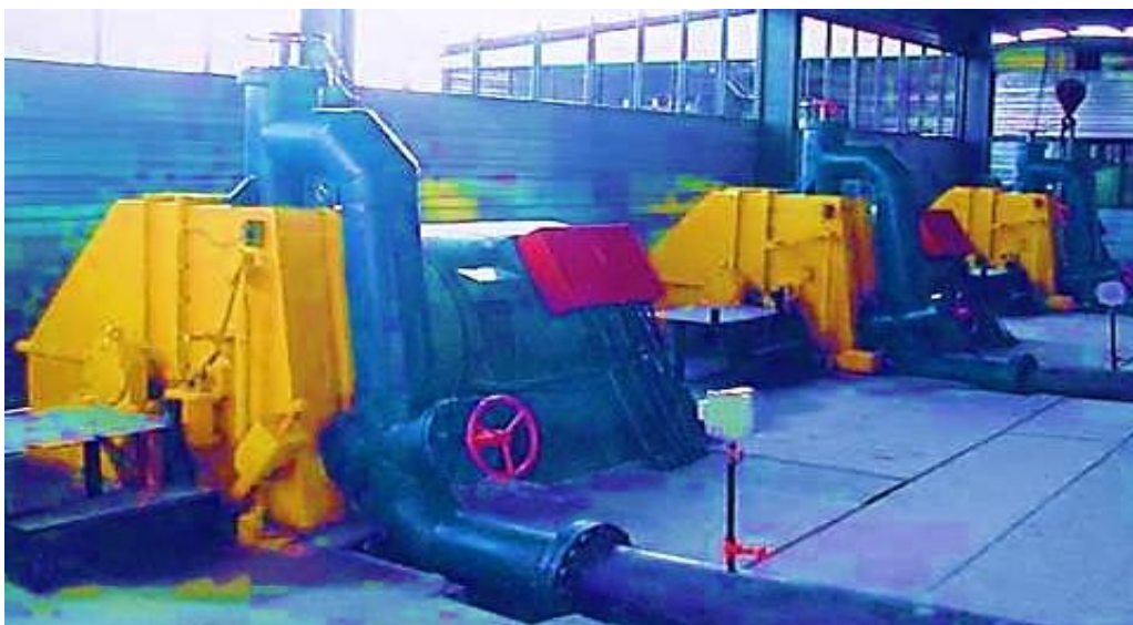
110-rasm. Vertikal o'rnatilgan cho'michli ish g'ildirakli kichik GES mashina zalining ko'rinishi.
